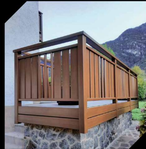
Alpilegno realizza poggioli in alluminio tramite l'utilizzo di profili con spessore importante ed estrusi da matrici realizzate su proprio disegno. L'assemblaggio avviene quasi completamente ad incastro senza viti a vista, i modelli realizzabili sono molteplici, personalizzabili dallo stile classico con piantoni da 90x90mm a quello più moderno con la struttura portante in acciaio inox.
